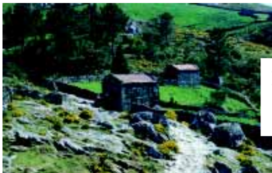
Cortelhos de dois pisos de planta rectangular
