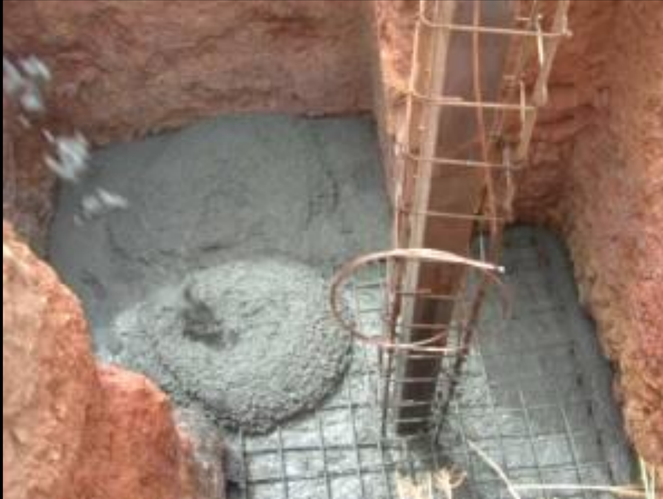
Betonagem dos caboucos
