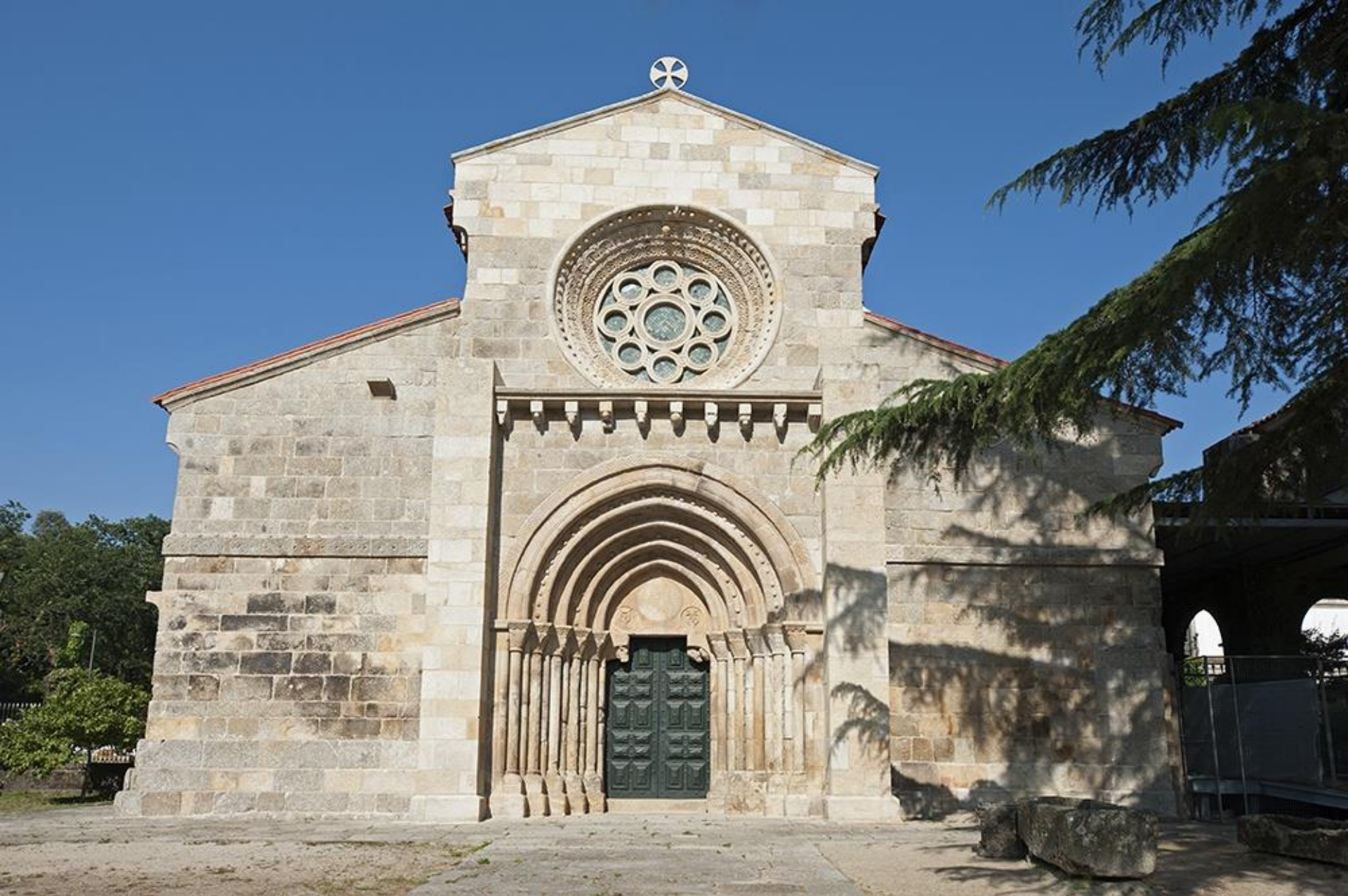
Mosteiro do Salvador de Paço de Sousa | Penafiel
